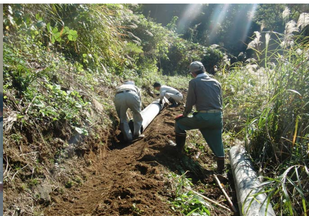
水路の修繕(白鳥農業改善組合)
