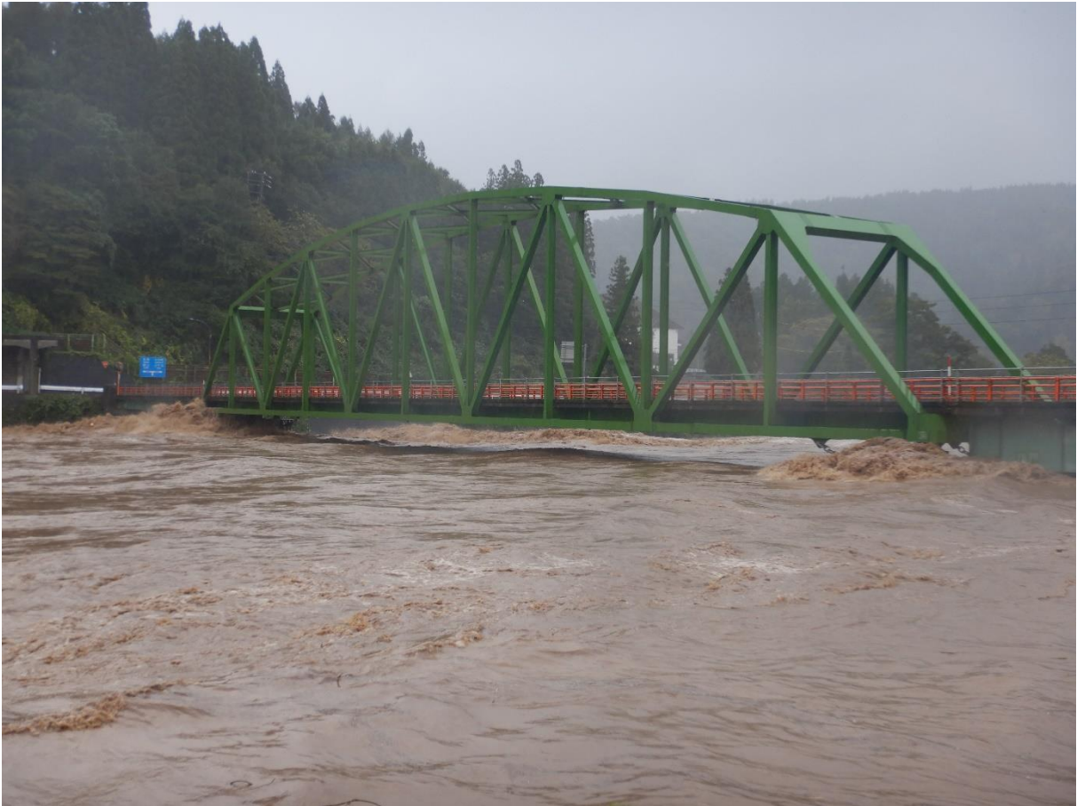
台風19号による大雨で増水した千曲川（令和元年10月13日 百合居橋）
