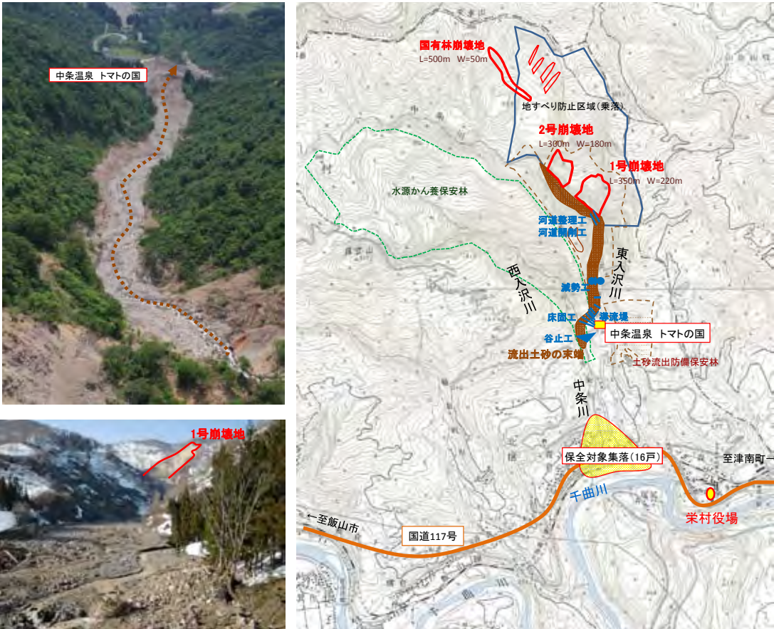
【図 6】中条川上流の土石流災害状況
