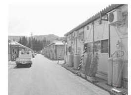
応急仮設住宅（栄村農村広場）
