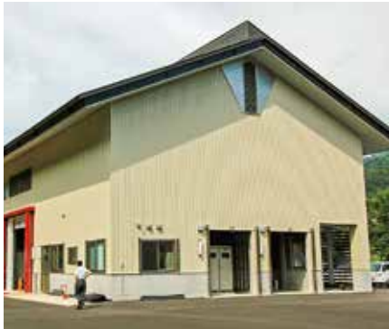
栄村ライスセンター（平成 26 年）
