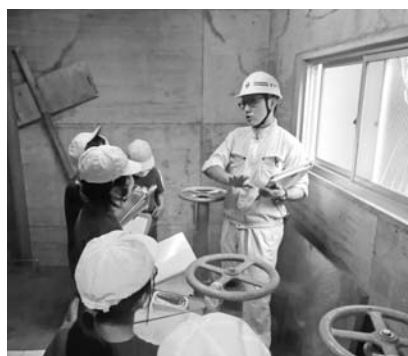
▲横倉配水池を見学中
