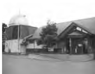
▲安曇野市：天平の森・薪ボイラー
