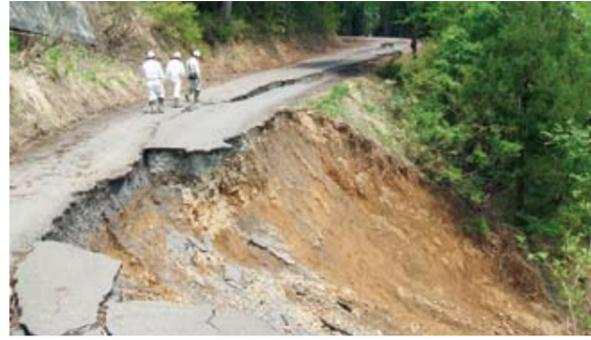
大きく亀裂が生じ、崩落した村道 [極野～五宝木]
