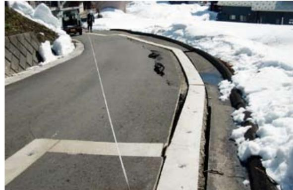
路面が陥没し、損壊した村道 [箕作]
