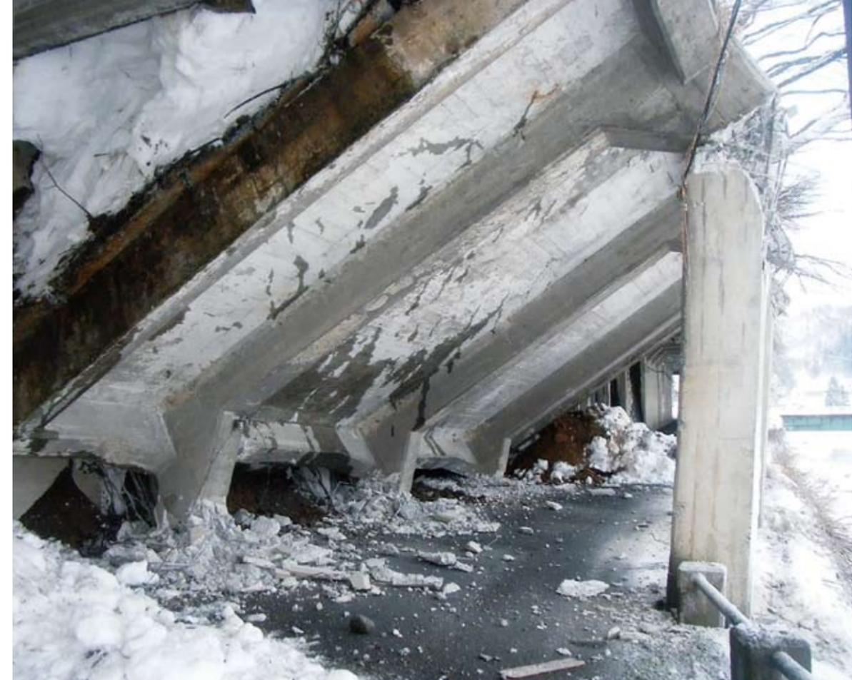
土砂崩落により倒壊した清水河原スノーシェッド(県道箕作飯山線)
