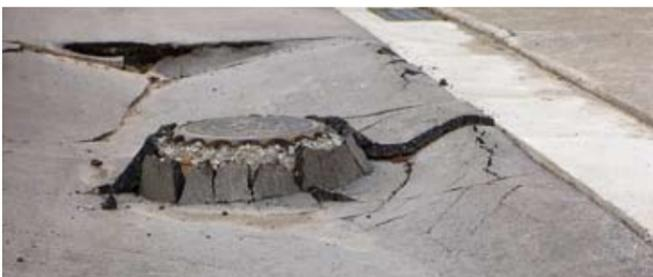
道路が陥没して浮き上がったマンホール
