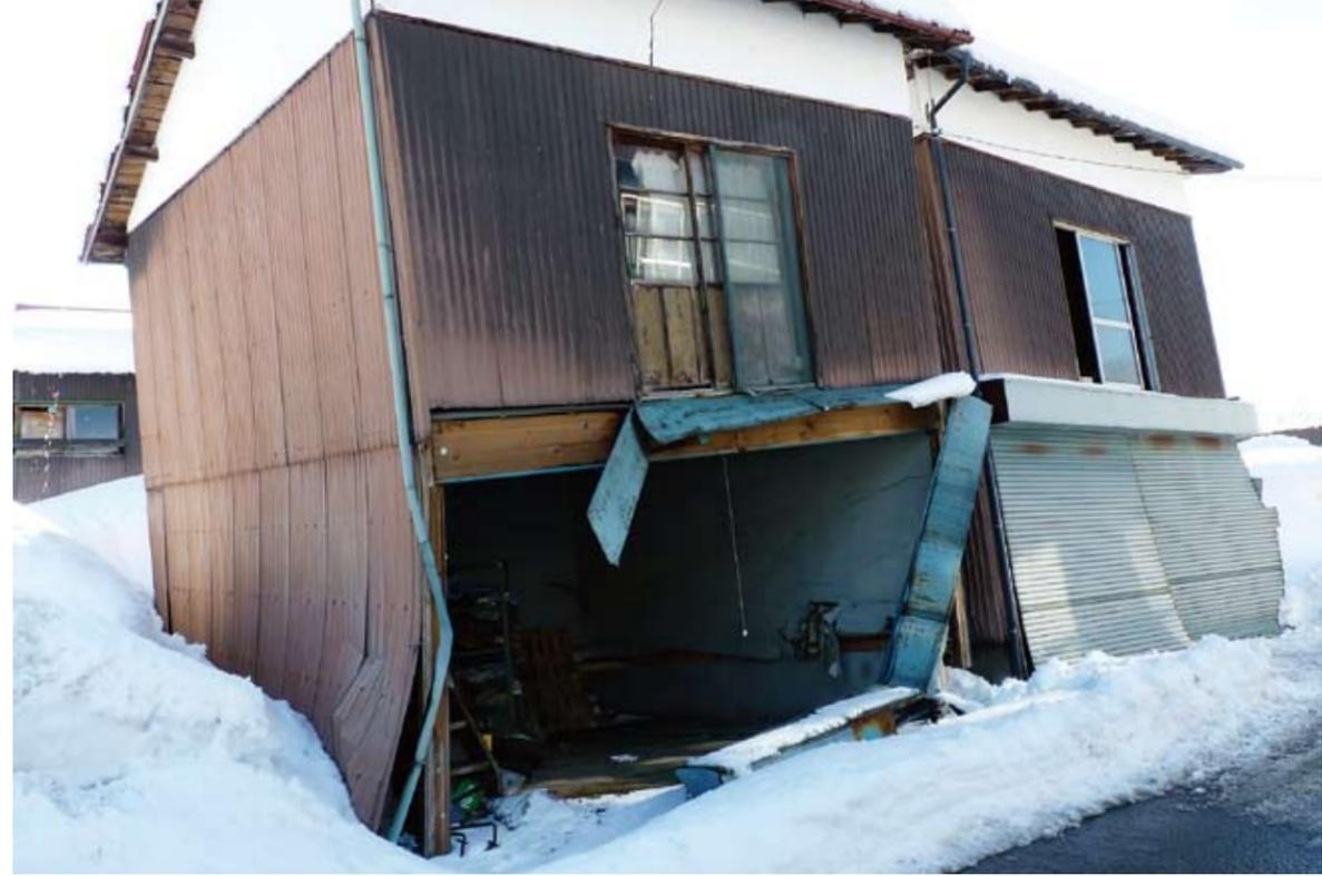
1階駐車スペースが傾き、損壊した建物 [小滝]
