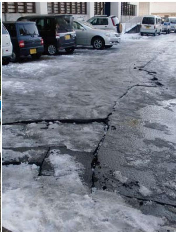
敷地のアスファルトにも大きな亀裂が生じた（栄小学校）
