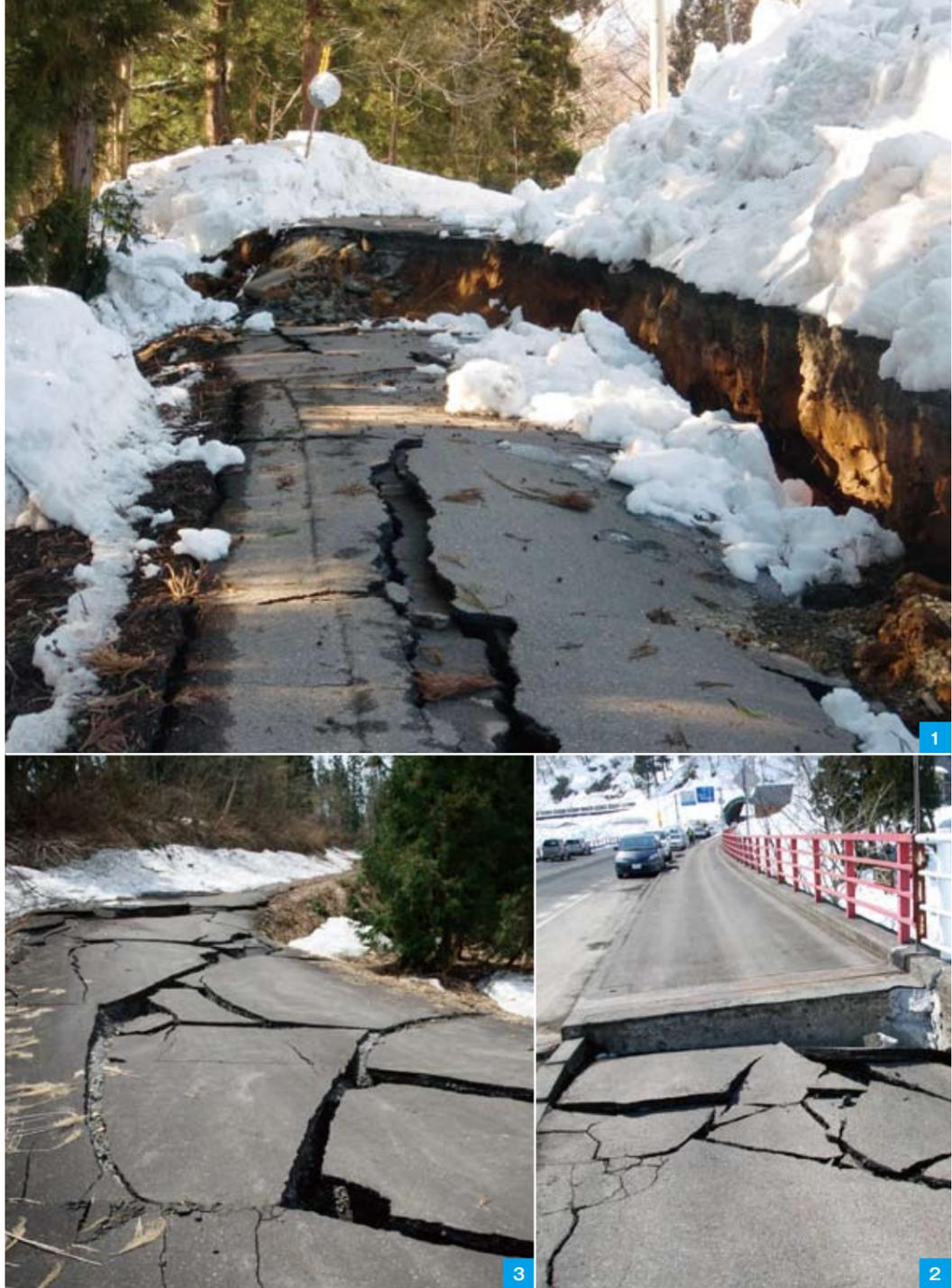
1 路面が大きく陥没し、段差が生じた県道長瀬横倉(停)線(貝廻坂) 2 損壊した北沢橋の取付部分
