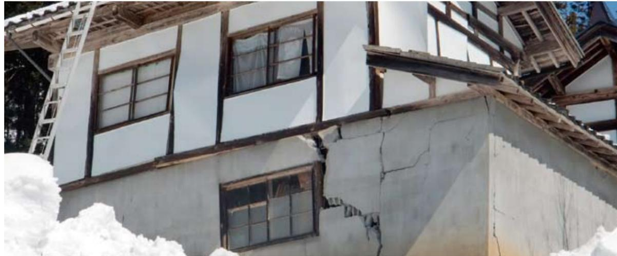
壁に大きく亀裂が生じ、損壊した建物 [天代]
