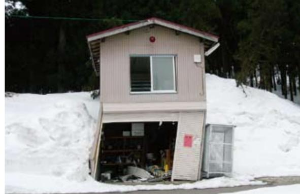
1階が傾き、損壊した消防ポンプ小屋 [野田沢]
