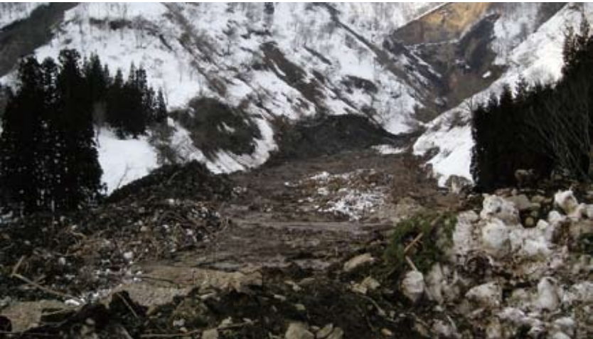
中条川上流で発生した土石流
