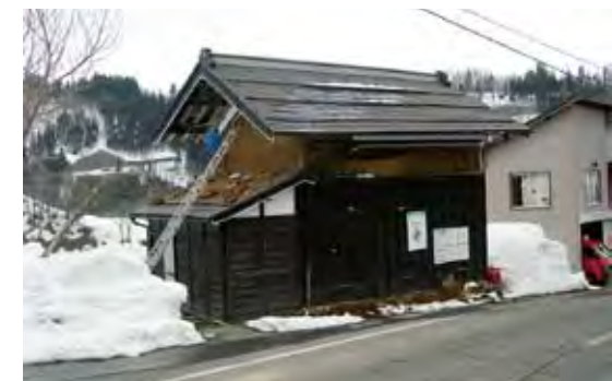
壁が剥がれ落ちた土蔵【北野】
