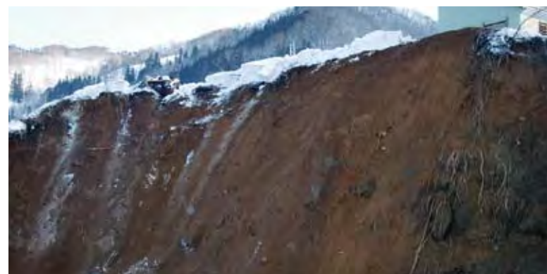
大規模な斜面崩落〔白鳥〕
