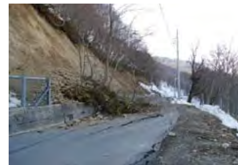
土砂が崩落した村道【和山】
