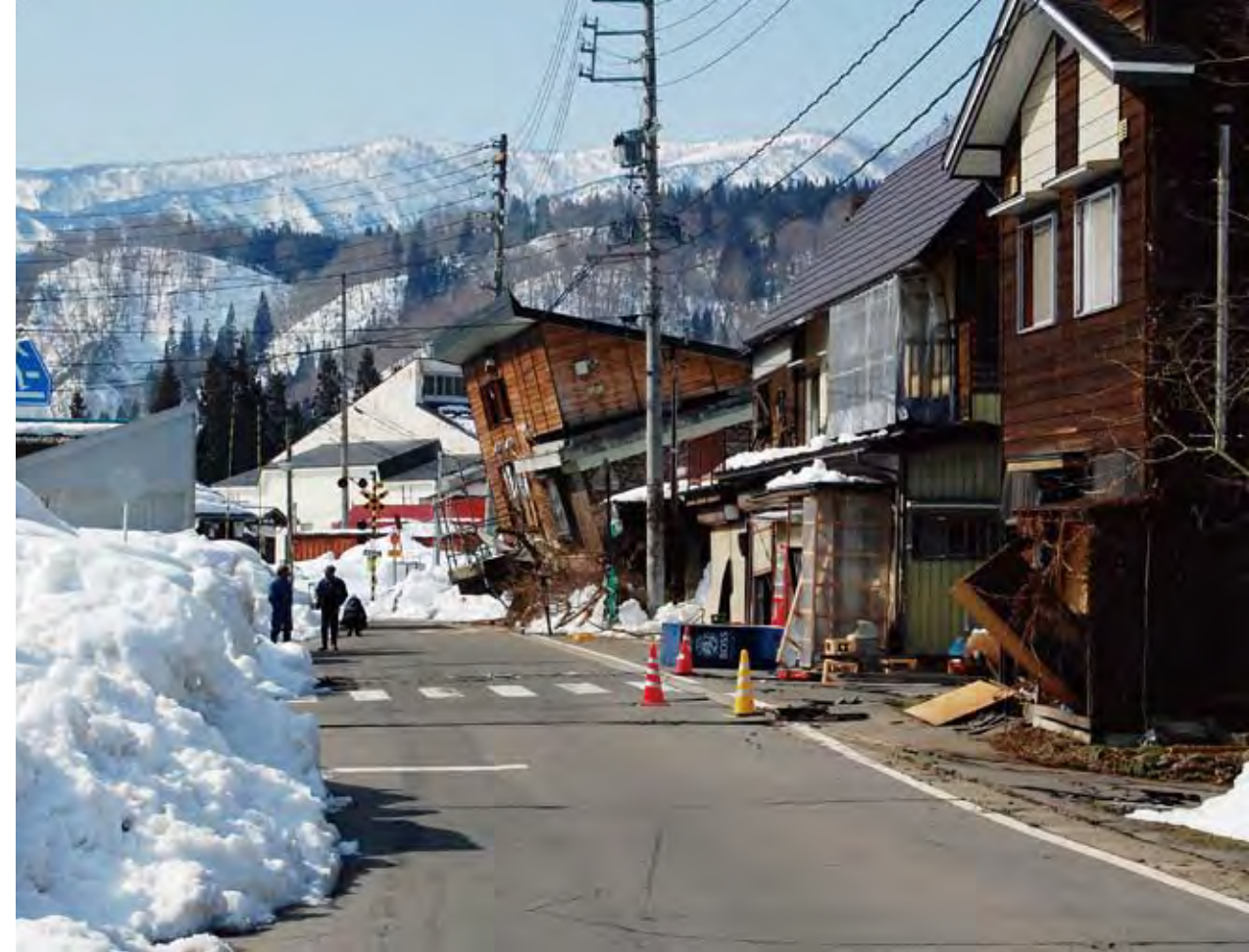
多くの家屋が損壊した横倉地区
