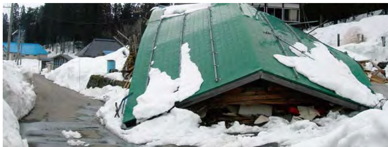
道路に向かって倒壊した建物 [野田沢]
