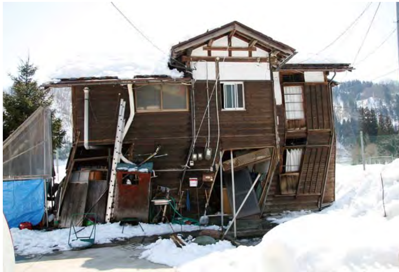
大きく傾き、損壊した家屋〔横倉〕
