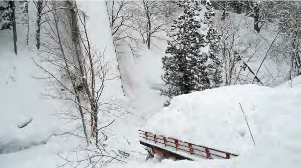
雪の重みで落橋した中条橋（平成24年1月）
