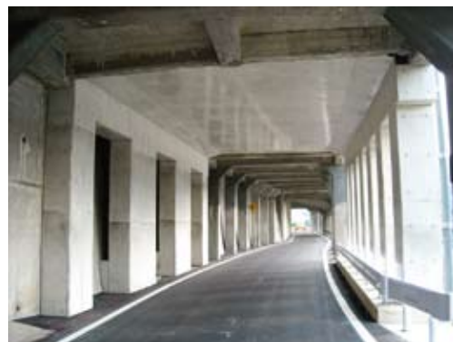
復旧状況（平成24年9月）
