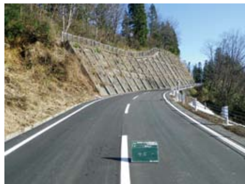
復旧状況（平成23年12月）
