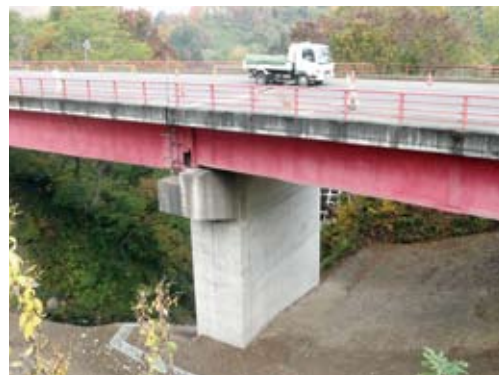
復旧状況（平成23年11月）
