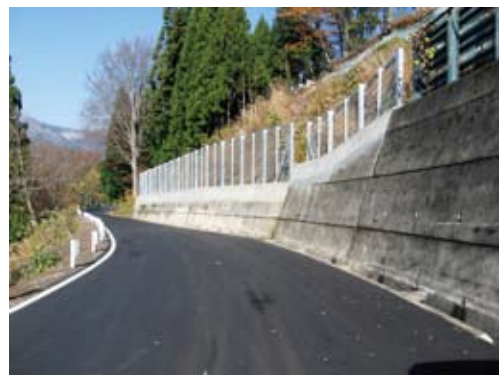
復旧状況（平成24年10月）
