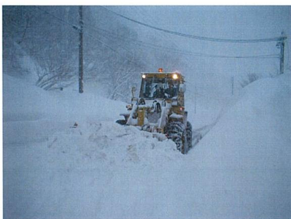
【除雪の手順①】タイヤドーザで道路に積もった雪を片側に寄せていきます。効率よく雪を寄せるためには、排土板（車体前方の雪を押し鉄の板）の高さや角度の絶妙な操作が必要です。
