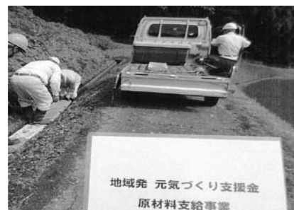
長瀬地区の作業の様子
