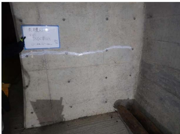
側壁部のひびわれ(ひびわれ幅3mm)
