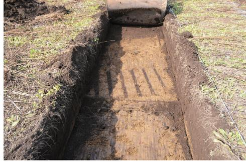
写真4 農地整備時の重機キャタピラ痕
