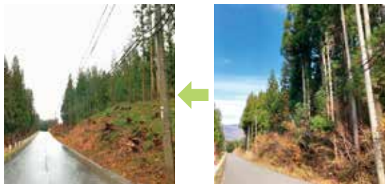
ライフライン保全対策事業
