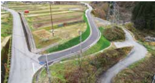
天代坪野線道路改良工事
