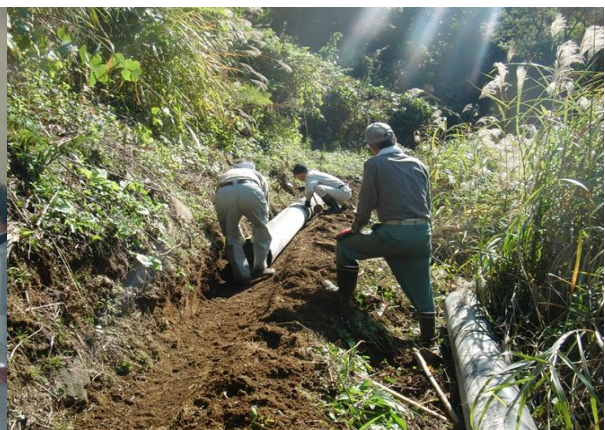
水路の修繕(白鳥農業改善組合)
