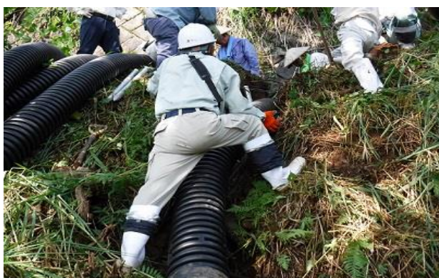
二次製品によるパイプラインの補修
