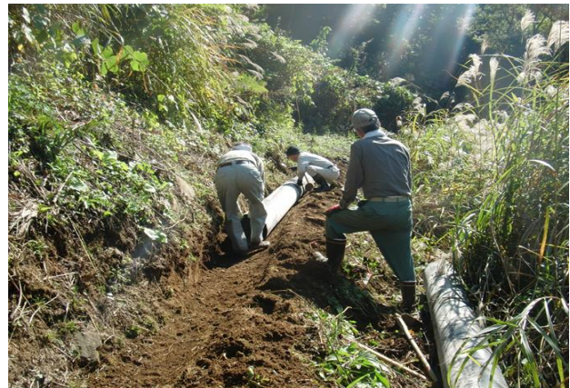
水路の修繕(白鳥農業改善組合)
