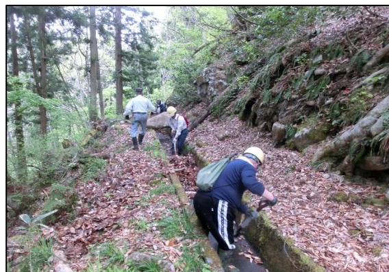
水路の泥上げ
