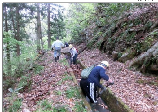
水路の泥上げ
