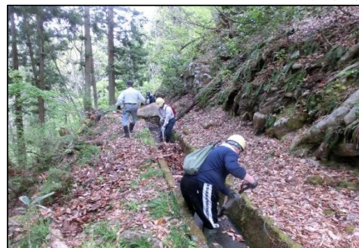
水路の泥上げ
