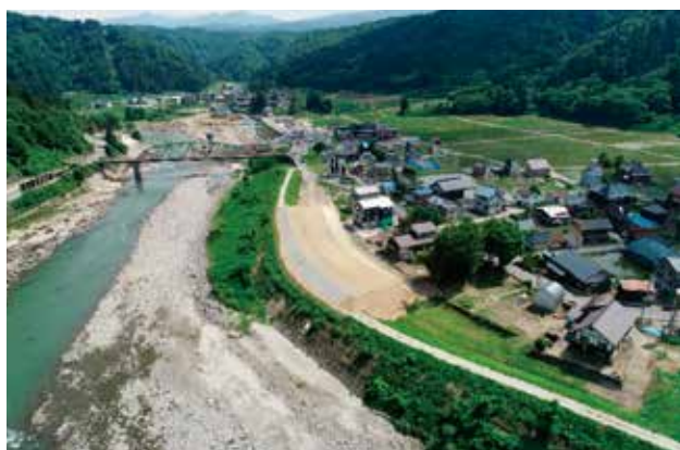
箕作側の築堤
