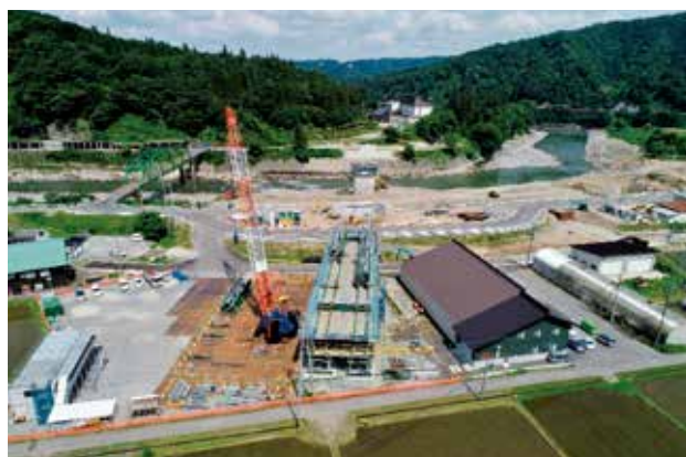
(株)横河ブリッジ施工現場
