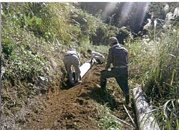
水路の修繕(白鳥農業改善組合)
