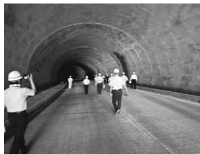
トンネルの内部
