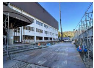
さて、現在工事は順調に進み、増設部分の基礎となる杭打ちは完了し、その上に柱を立てる作業を行っております。雪が本格的に降るまでに、増設部分の屋根と壁をつける作業を完了させ、12月頃からの降雪時期は、内部の改修工事に作業が進む予定です。
