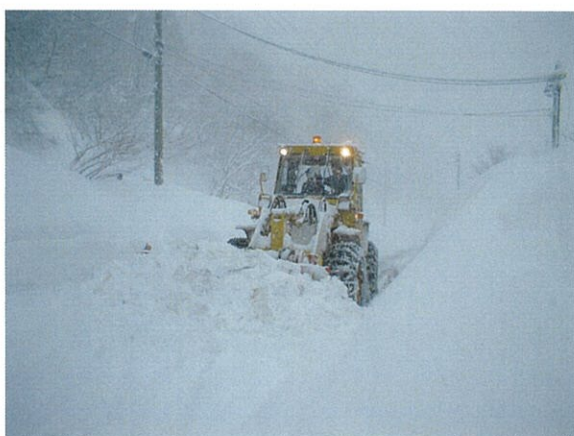
【除雪の手順①】タイヤドーザで道路に積もった雪を片側に寄せていきます。効率よく雪を寄せるためには、排土板（車体前方の雪を押す鉄の板）の高さや角度の絶妙な操作が必要です。
